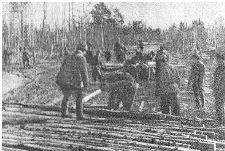
Строительство дорог на Волховском фронте
